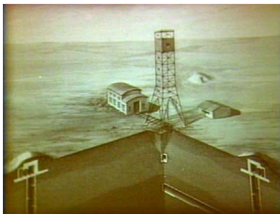
Центральная часть опытного поля при испытании РДС-1 на Семипалатинском испытательном полигоне. (Архив Минатома)
